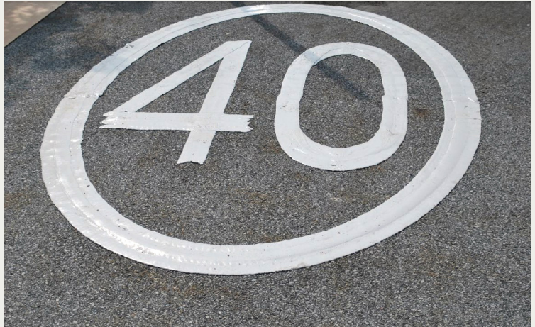
Bild 2. Resultat vid målning hastighetsbegränsning, max 40 km/t.
